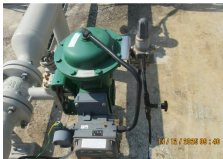
ภาพที่ 2-9 วาล์วระบายความดันที่หอเผา/วาล์วฉุกเฉิน
