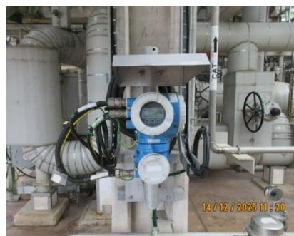
ภาพที่ 2-36 ติดตั้งบล็อควาล์วที่ท่อ และเครื่องตรวจวัดอัตราการไหล
