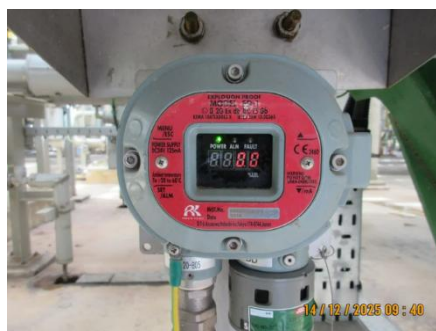
ภาพที่ 2-8 Gas Detector
