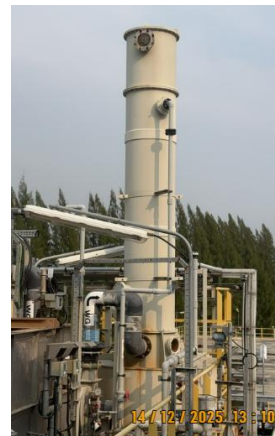
ภาพที่ 2-15 หน่วยบำบัดกลิ่นแบบสครับเบอร์ จำนวน 2 ชุด
