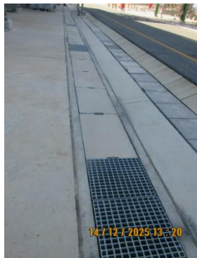
ภาพที่ 2-17 รางระบายน้ำในพื้นที่โครงการ
