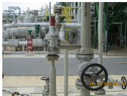
ภาพที่ 2-9 วาล์วระบายความดันที่หอเผา/วาล์วฉุกเฉิน
